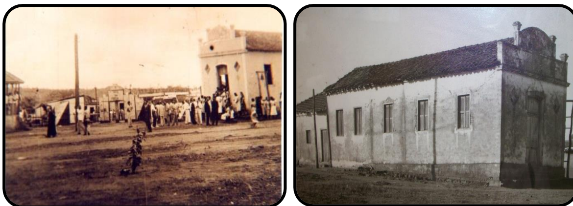
Foto: 134 e Foto: 135 - Capela Santa Rosa de Lima Fonte: SEMPAC
