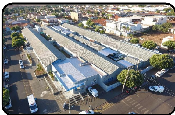
Foto 129 - Hospital do Povo / Ambulatório - Fonte: SEMPAC
