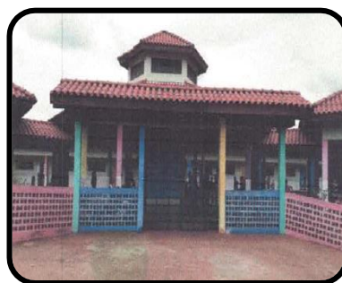
Foto 101: Escola Municipal Lourival Baptista Câmara Fonte: SEMPAC
