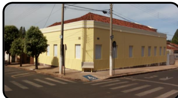
Foto - 133 - Prédio do Antigo Grande Hotel - 2017 O prédio foi reformado em 2017 para abrigar a Secretaria Municipal de Cultura. Fonte: SEMPAC
